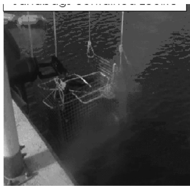
图 7 局部水域放射性去污沙袋
